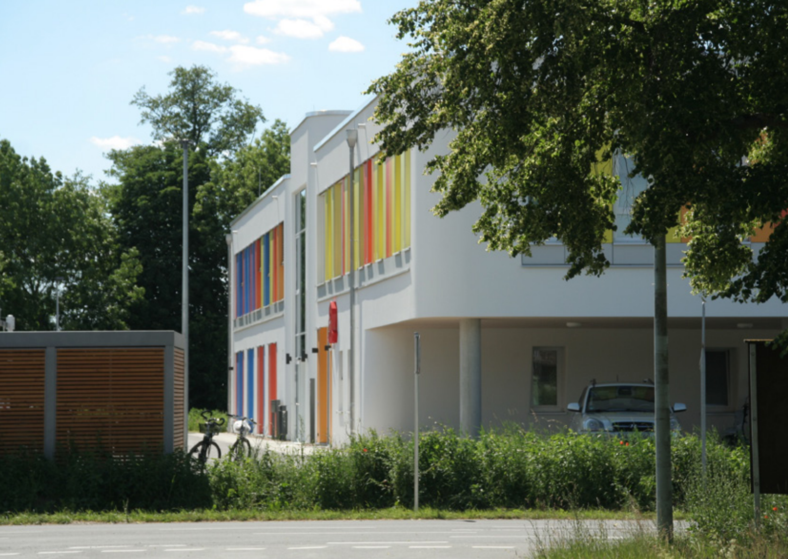
Das farbenfrohe auffällige Fensterband spiegelt die unterschiedliche Nutzung durch Apotheke, Geburtshaus, Arztpraxis und Bankfiliale.
